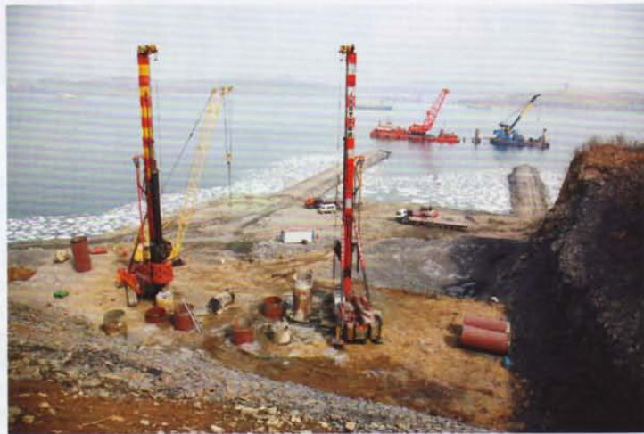
На о. Русском все готово к началу бурения пилонной опоры
