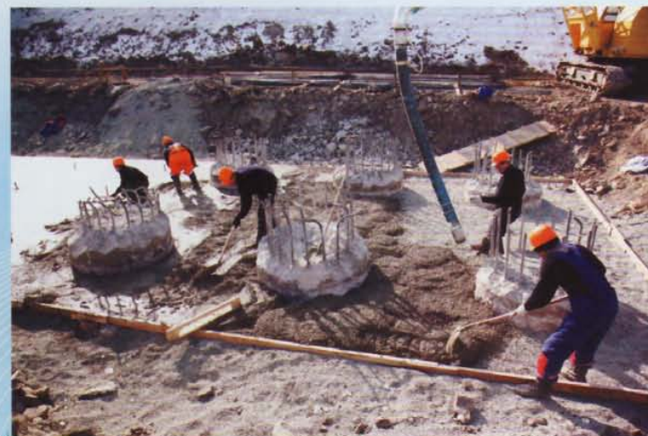
Бетонирование ростверка
