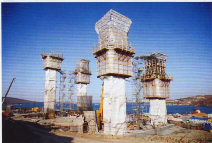
На полуострове Назимова работы идут на 11 эстакадах
